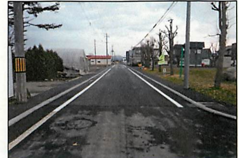
施工後 (H30 施工区間)
