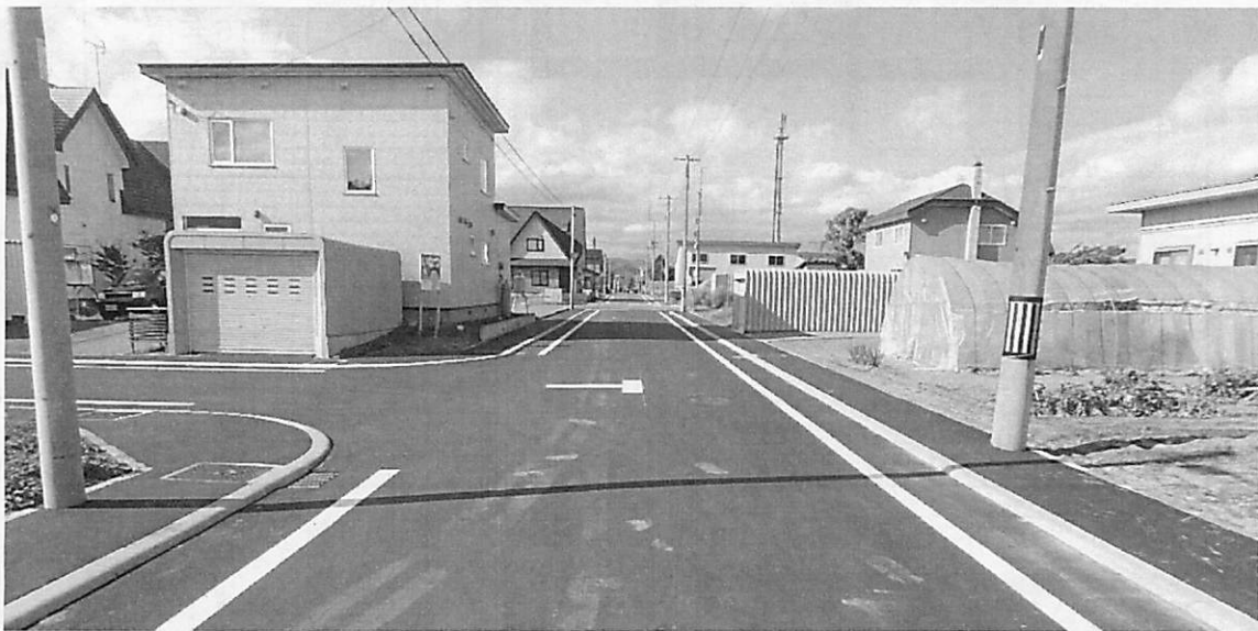
改修後の写真
